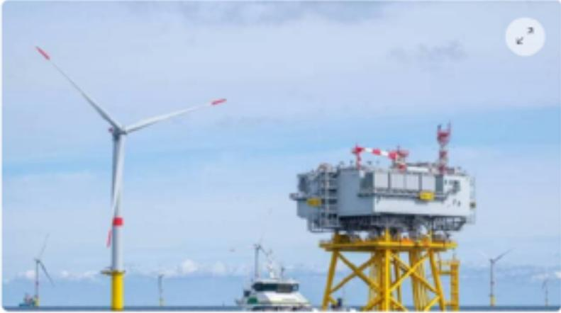
La sous-station électrique, sorte de gros transformateur construit par les Chantiers de l'Atlantique, est installée au beau milieu d'un champ de 80 éoliennes espacées chacune d'1 km | PRESSE Océan-SIMON TORLCTIN
