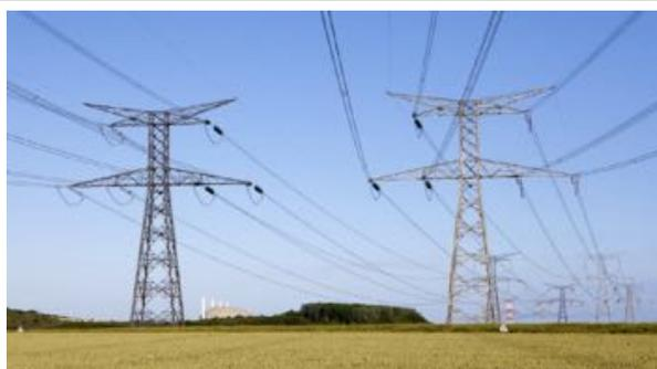
Le transport se fait au moyen de lignes à très haute tension (400 000 Volts, ou 400 KV) pour limiter les pertes en lignes. Malgré cela, RTE annonce des pertes de 2 à 3% de la production (sous forme de chaleur) dans le transport de l'électricité.
