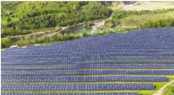
Ces panneaux que l'on peut trouver un peu partout, sur des poteaux de signalisation isolés, sur le toit des maisons ou sur des surfaces dédiées plus importantes exploitent la capacité du silicium (mais aussi d'autres semi-conducteurs) à produire un courant continu sous l'effet d'un rayonnement. Il s'agit bien sûr, comme nous l'avons vu, d'une transformation de l'énergie lumineuse en
