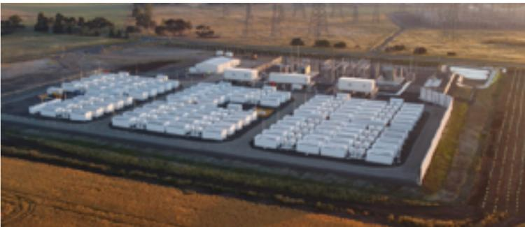
Ceci est la Victorian Big Battery (Australie), la plus grande batterie au lithium au monde. Sa capacité est de 450 MWh. Dans notre exemple, cette giga batterie n'absorberait la production de nos 10 éoliennes que pendant 22h30 ! Et cette batterie coûte environ 160 M€, ce qui augmente significative-
